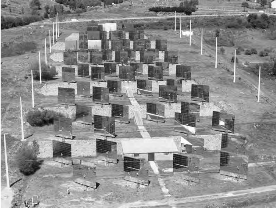
Fig. 15.16. Les héliostats redirigeant les rayons vers le four solaire d'Odeillo (photo de Serge Chauvin)
